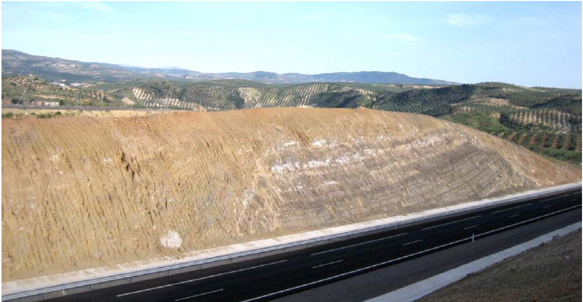
Figura 2.5.6.- Olistolito de dolomías de edad triásico dentro de brechas (debritas). Parte brechificada en borde externo del olistolito
